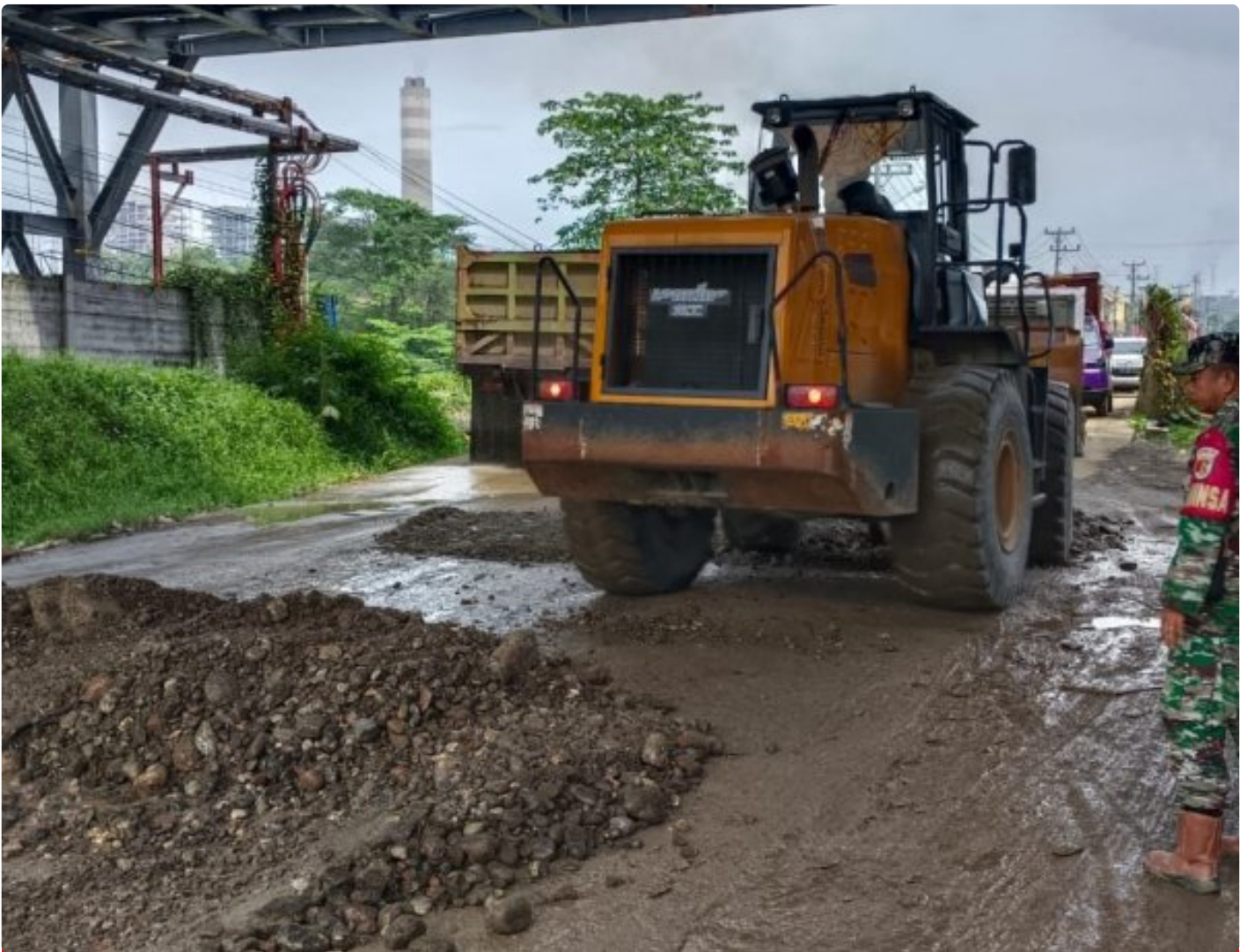
Penimbunan Jalan Rusak di Desa Labota
