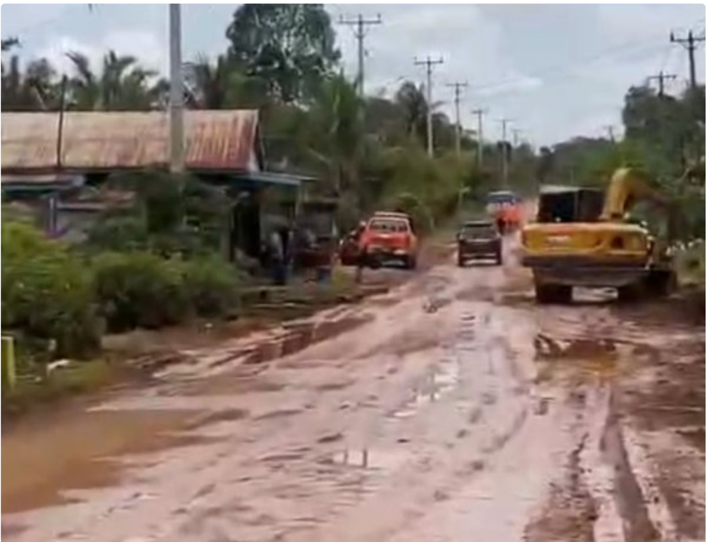
Tampak banjir lumpur kuning kemerahan menggenangi jalan poros lintas di Solonsa Jaya
